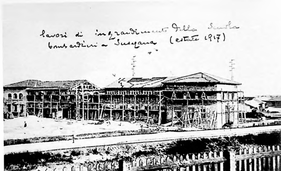
7. Scuola bombardieri di Ponte Priula in costruzione.
