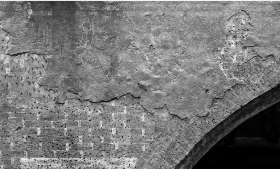
Fig. 8 - Particolare di decorazione a finti mattoni su casa in via S. Agostino 61, al di sotto dell'intonaco decorato del XVI secolo
