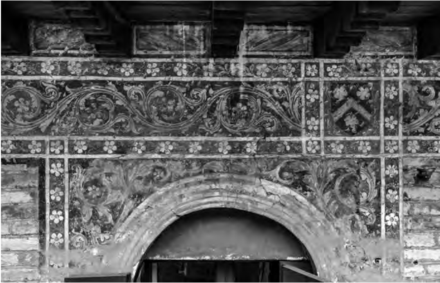
Fig. 10 - Particolare della decorazione di casa Spineda-Agostini in via S. Nicolò 9-13
