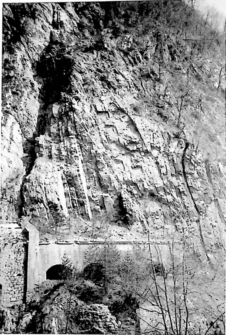
FIG. 5. - Passo della Morte: l'attuale galleria.
