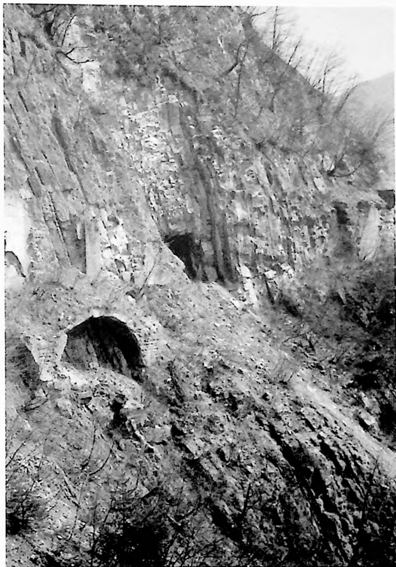
FIG. 4. - Passo della Morte: tracce della strada.
